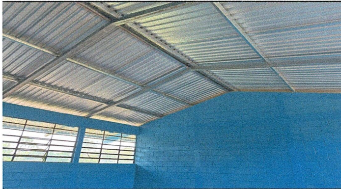
Foto 1: Asi quedo la estructura del techo del modulo 1
