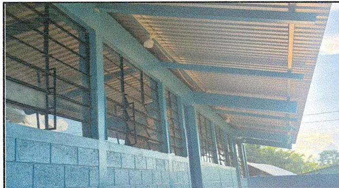
Foto 3: Asi quedo instalada la energia electrica
