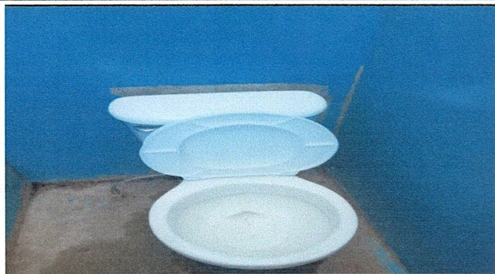
Foto1: Asi quedaron los nuevos sanitario
