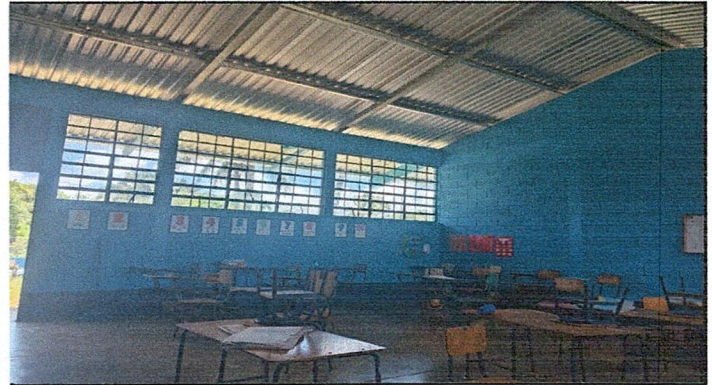
Foto 2: Asi quedaron las paredes del interior del establecimiento
